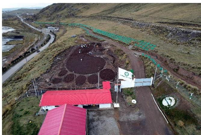
**Figura 7.** Construcción de pozas de biotratamiento de DAM.
